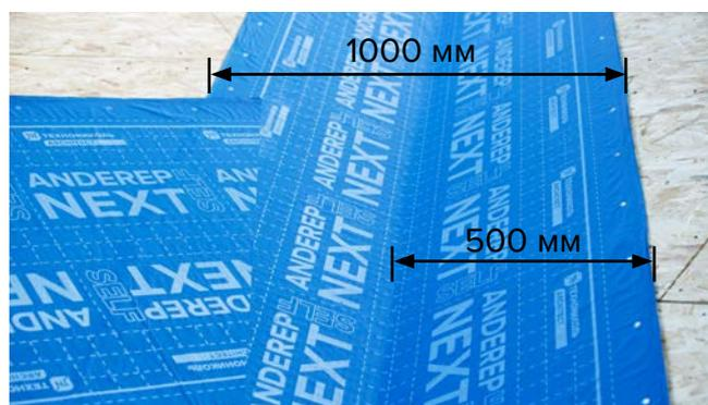
Сначала самоклеящийся подкладочный ковер укладывается в ендове, согласно правилам укладки материала – пункт 4.1.
