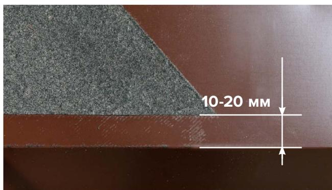
На карнизном свесе самоклеящийся подкладочный ковер подрезается и укладывается так, чтобы до перегиба карнизной планки остался зазор 10–20 мм. На нижнем краю ендовы ковер необходимо подрезать с небольшим закруглением («язычком»), для того чтобы закрыть стыки карнизных планок в ендове и обеспечить правильный отвод воды.
