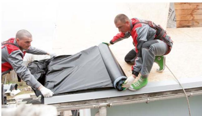
Затем приклеить оставшуюся часть полотна, одновременно раскатывая и снимая защитную пленку с рулона.
