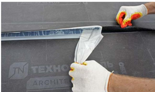
Продольный перехлест подкладочного ковра ANDEREP GL PLUS / GL PLUS (S) формируется с помощью клеевой и битумной монтажных полос. Для формирования перехлеста необходимо одновременно снять защитные пленки с полос верхнего и нижнего полотен и плотно прижать их друг к другу.
