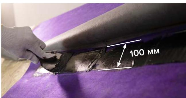
**Продольный перехлест подкладочных ковров составляет 100 мм.** Места продольных перехлестов подкладочных ковров ANDEREP PROF (500) и ANDEREP GL LIGHT промазываются битумной приклеивающей мастикой ТЕХНОНИКОЛЬ № 23 (Фиксер), толщиной не более 1 мм.
