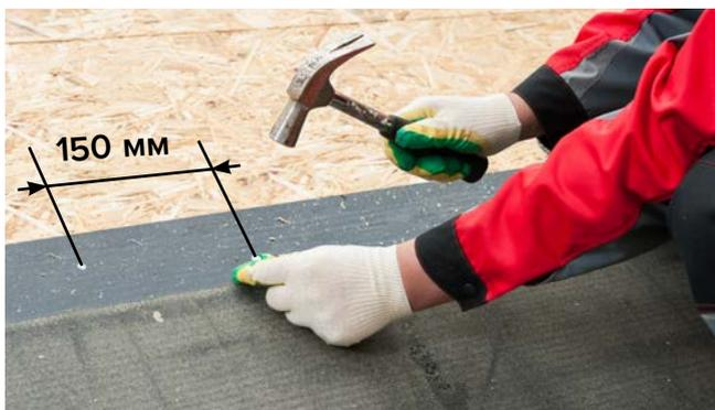
Выполнить механическую фиксацию материала ершеными кровельным гвоздями в зоне продольного перехлеста. Шаг крепления гвоздей составляет 150 мм и выполняется в разбежку.
