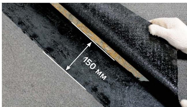
Поперечные нахлесты составляют 150 мм. Место поперечного перехлеста подкладочного ковра ANDEREP ULTRA промазывается тонким слоем битумной мастики ТЕХНОНИКОЛЬ № 23 (Фиксер).
