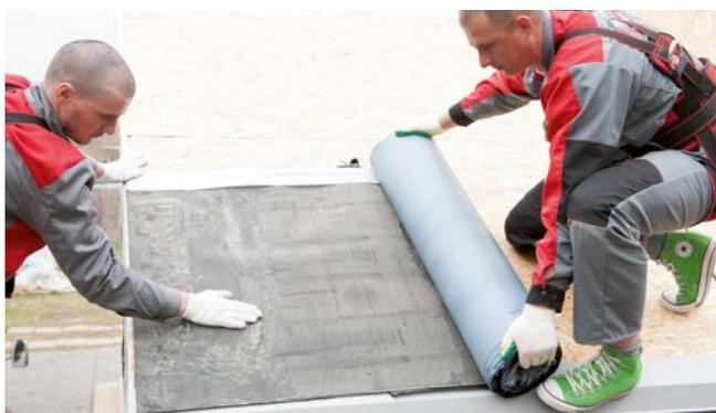
Выровнять и приклеить часть полотна к основанию, оставшуюся часть завернуть до места приклейки материала.
