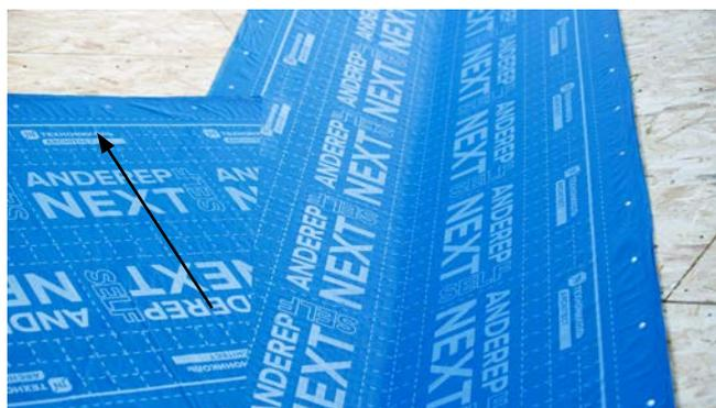
По остальной площади подкладочный ковер монтируется снизу вверх, параллельно карнизному свесу согласно правилам укладки материала – пункт 4.1.
