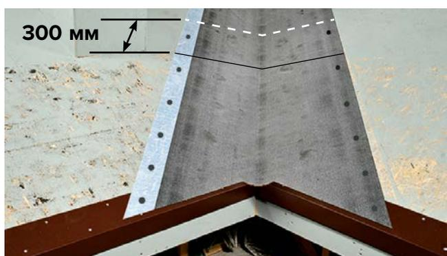
При возникновении нахлеста материала в зоне ендовы он выполняется в верхней ее части. Ширина поперечного перехлеста в зоне ендовы составляет 300 мм.
