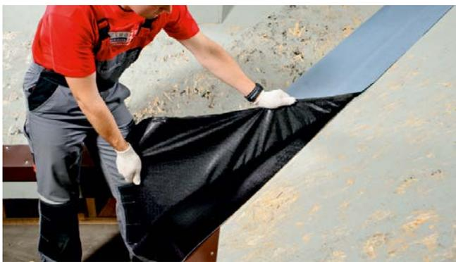
Затем таким же образом удаляется пленка со второй половины подкладочного ковра.
