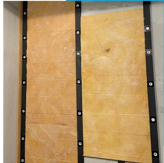
В качестве обшивки могут применяться различные листовые материалы с разной эффективностью, при этом наибольшая эффективность будет достигнута при монтаже листов Soundline-db и ГКЛА АКУ-Line. Саморезы первого слоя закручиваются с шагом 500 мм, финишного - с шагом 200-250 мм.
