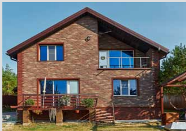
Объект «ПОСЛЕ». Коллекция КИРПИЧ, цвет Английский кирпич
